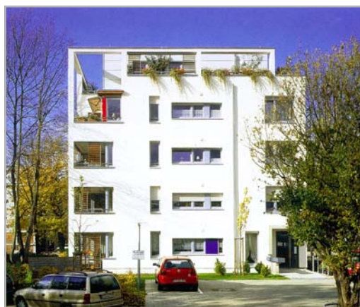
Immeuble d'habitation, Konstanz, Allemagne
