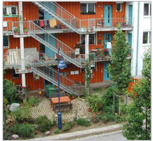
Transition rue-bâtiment, quartier Vauban, Fribourg en Brisgau
