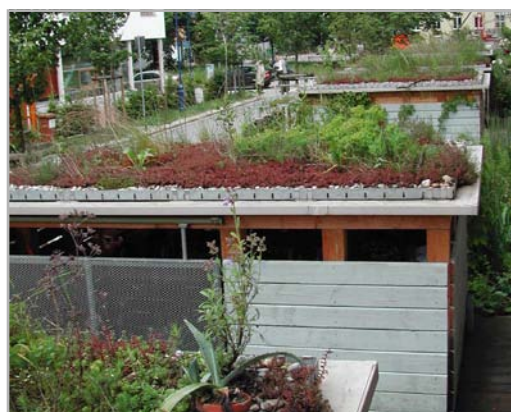
Toiture végétalisée, Fribourg en Brisgau
