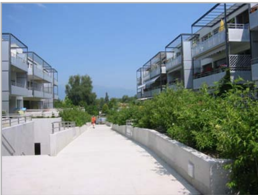
Confignon, Cressy, cheminement interne
