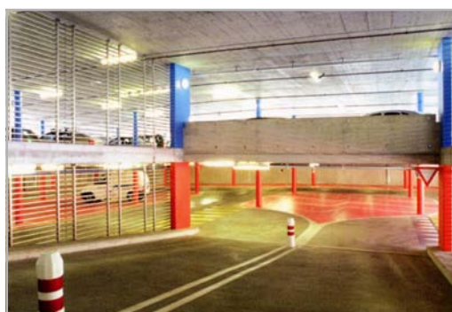
Parking mi-enterré de Sous-Moulin, Thômex
