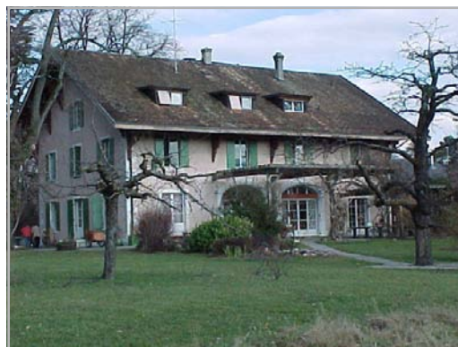
Bâtiment du CAD (Ancien preventorium)
